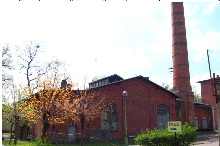
Widok budynku od północy
