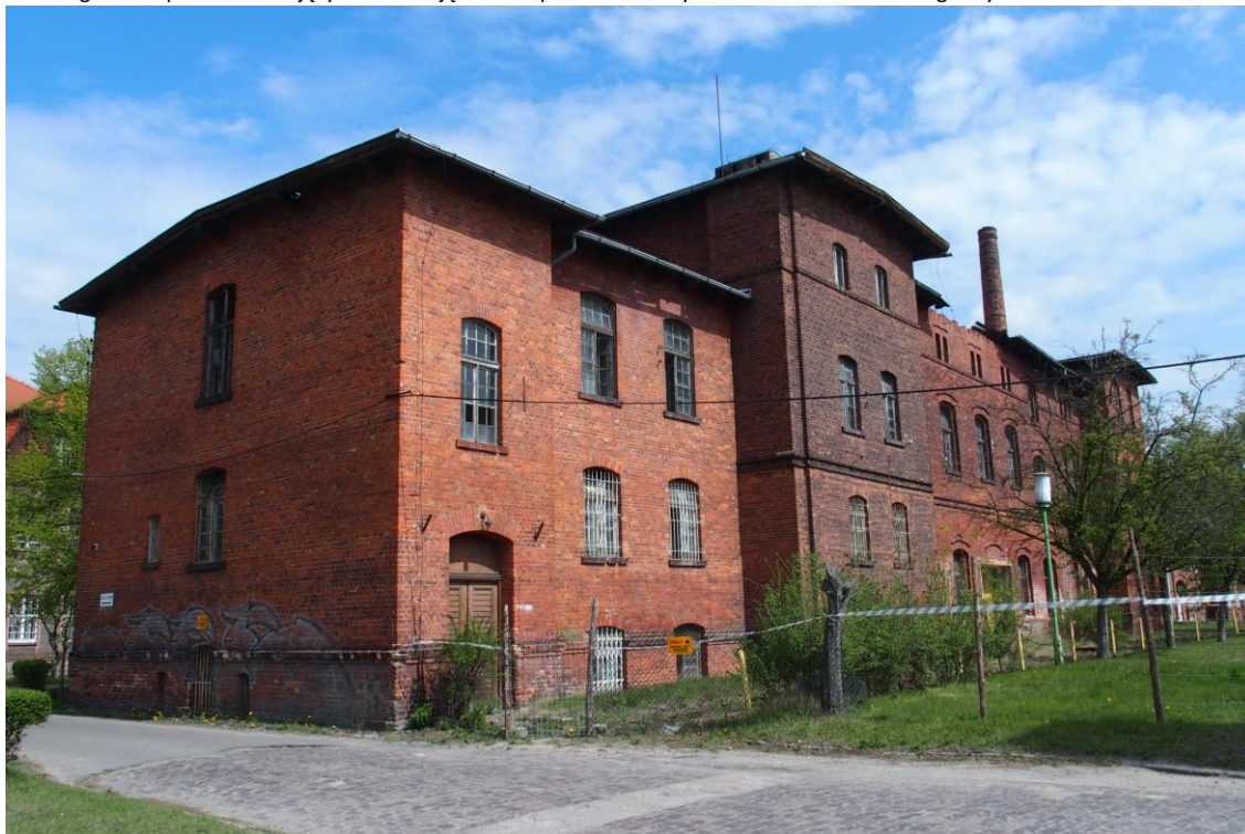
Widok budynku od południowego - zachodu
