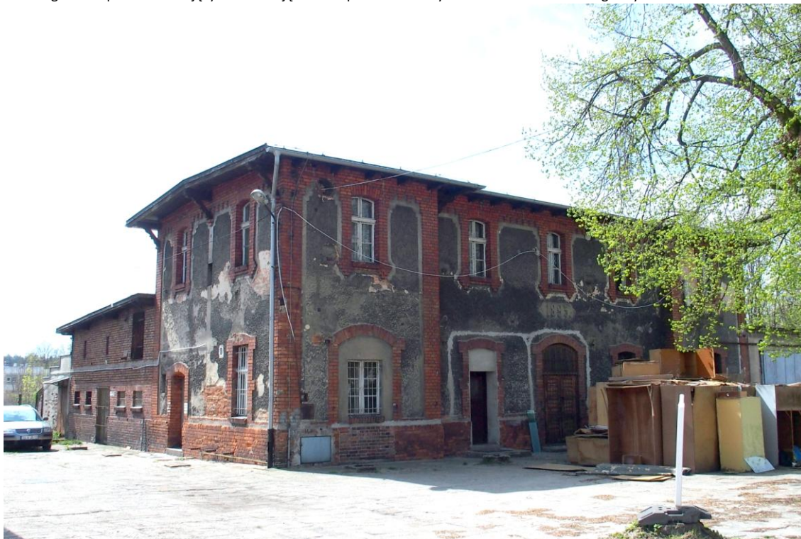
Widok budynku od północnego - wschodu
