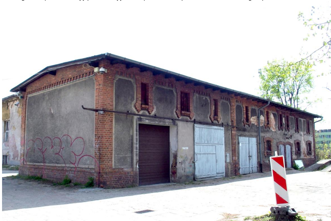
Widok budynku od północnego - zachodu
