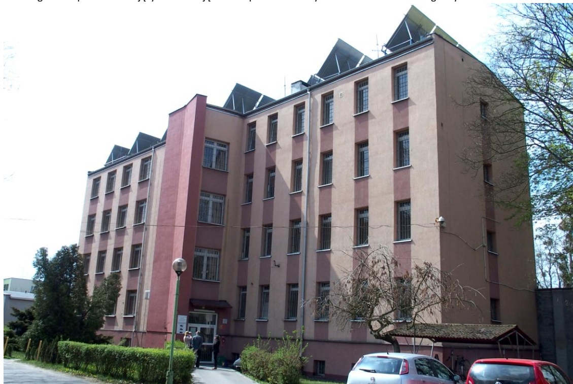
Widok budynku od północnego - wschodu
