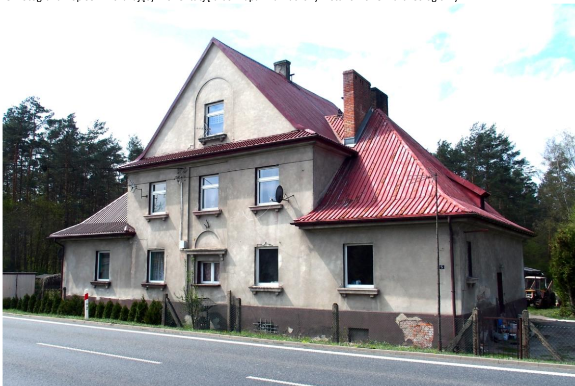
Widok budynku od północnego - wschodu
