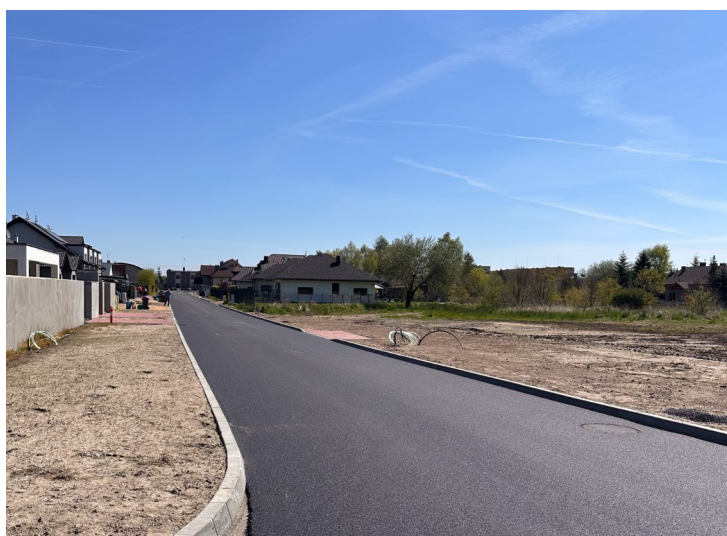
Przebudowa ulicy Górniczej
