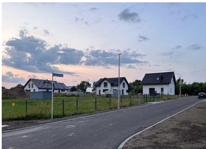
Przebudowa ulicy Hadyny
