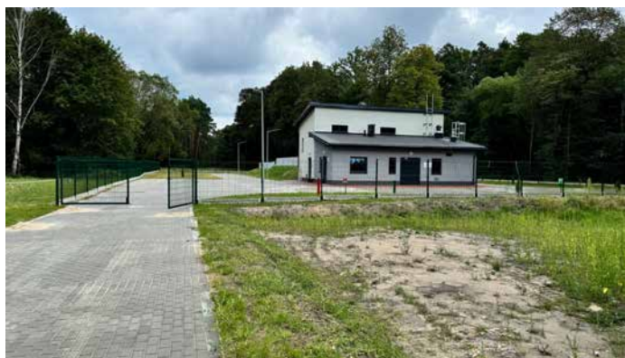
Oczyszczalnia ścieków w Kokotku
