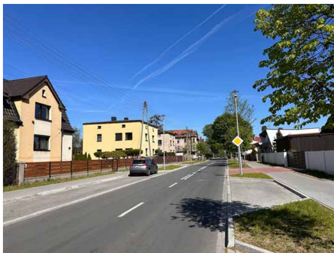
Przebudowa ulicy Plebiscytowej
