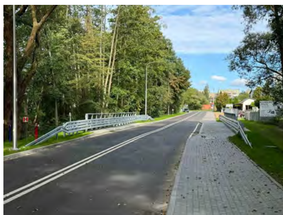
Przebudowa mostu w ciągu ulicy Spokojnej
