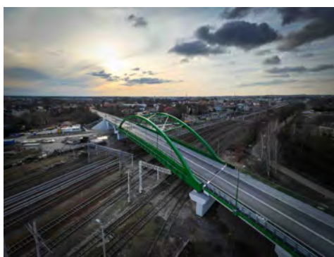
Nowy wiadukt w ciągu drogi wojewódzkiej numer 906 w Lublińcu
