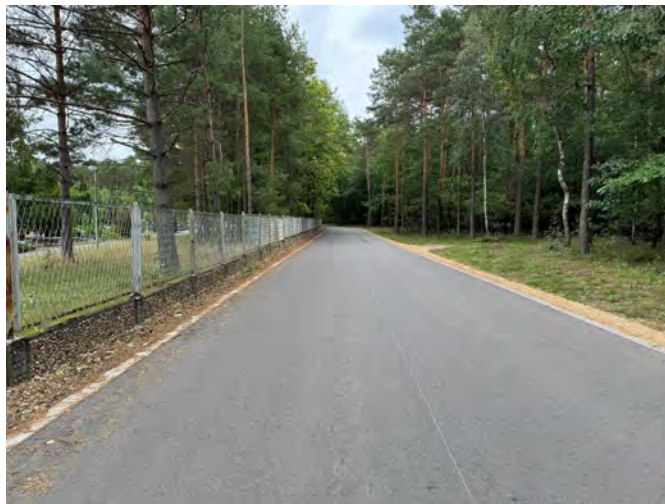
Remont nawierzchni ulicy Cyrana
