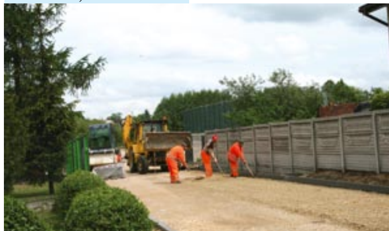
Przy ul. Stawowej powstaje dojazd do nowego boiska i miejsca parkingowe.
