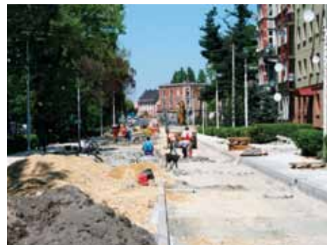
Przebudowa ul. Paderewskiego
