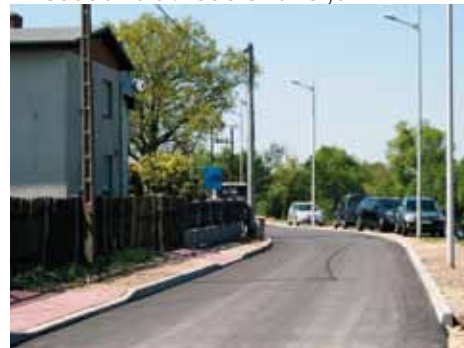
Przebudowa ul. Stawowej
